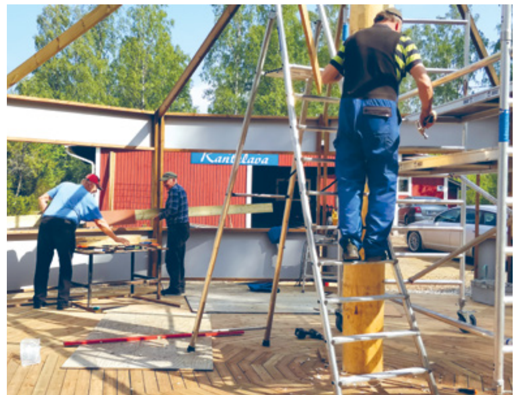
Seppo Kivelä, Reino Lahti ja Arno Koskela uutta pömpeliä rakentamassa.
